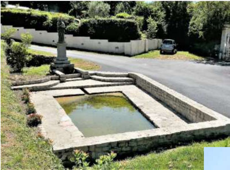
Fontaine St Pierre. Construite en 1871 ; Fontaine et lavoir réaménagés.
